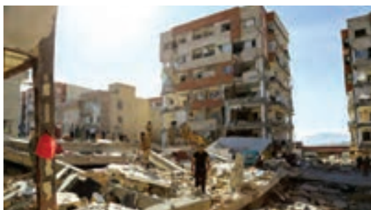
شکل ۹-الف- زلزله کرمانشاه
